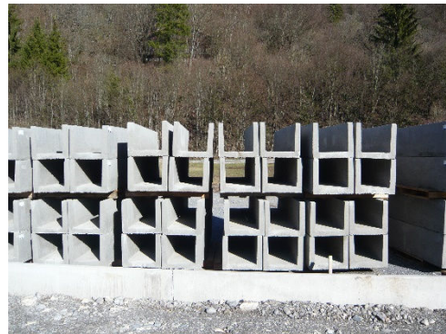
Le chantier du Bout du Lac
